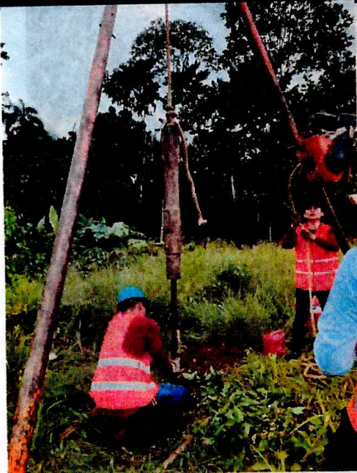
Fotografía 10-17: Ensayo SPT, perforación P17
