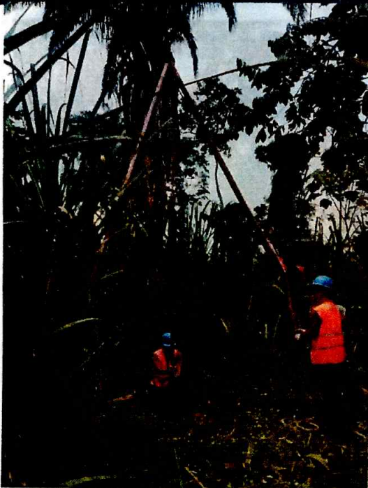
Fotografía 10-2: Ensayo SPT, perforación P2
