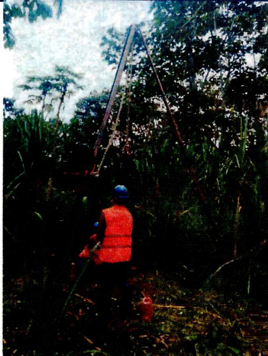
Fotografía 10-13: Ensayo SPT, perforación P13
