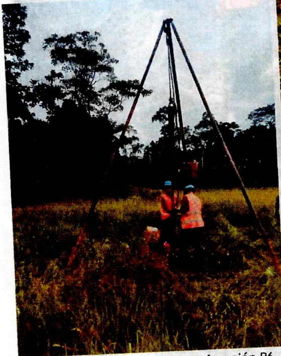
Fotografía 10-6: Ensayo SPT, perforación P6
