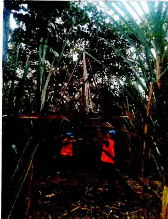
Fotografía 10-3: Ensayo SPT, perforación P3
