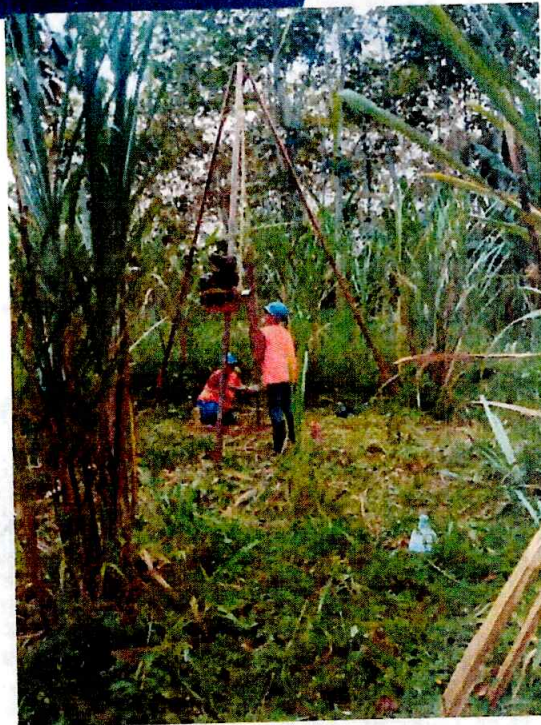
Fotografía 3-3: Ensayo SPT, Perforación P13 Fuente: Elaborado Equipo Consultor
