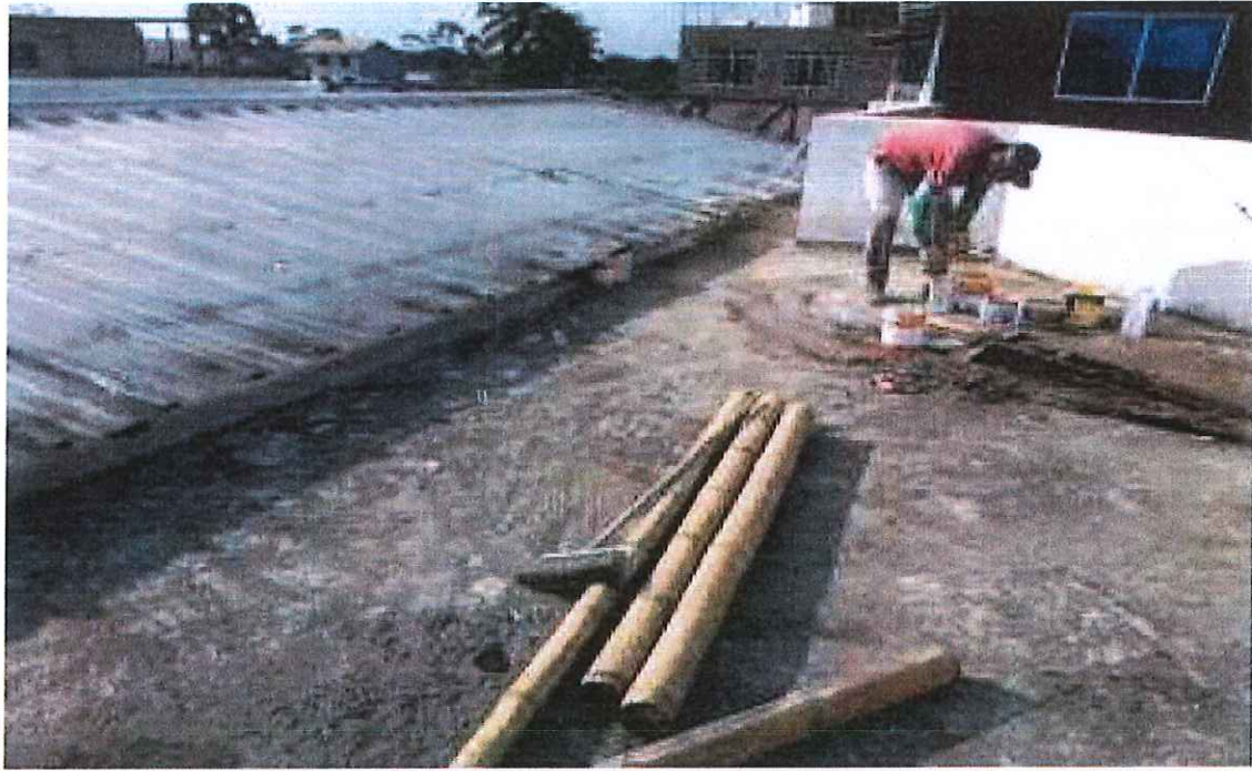
Implementación de filos en la terraza del edificio
